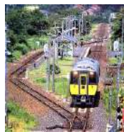
行き違い設備改良
