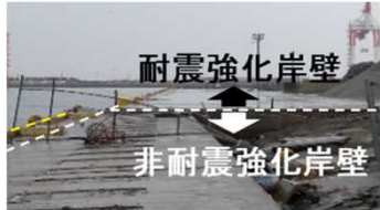
耐震強化岸壁の整備
