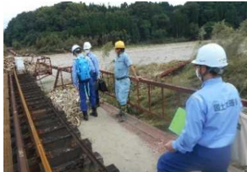
TEC-FORCEによる被災鉄道の現地調査
