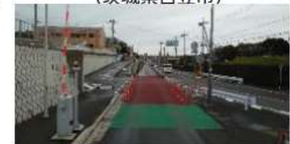
専用道の設備（茨城県日立市）19
