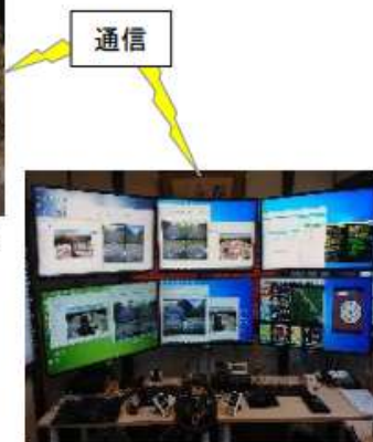
遠隔監視・操作室
