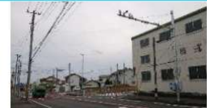
交差点でのインフラ連携設備 （茨城県日立市）
