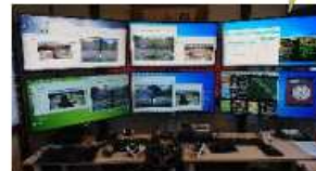
遠隔監視・操作室
